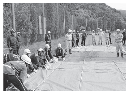
シート張り工法
